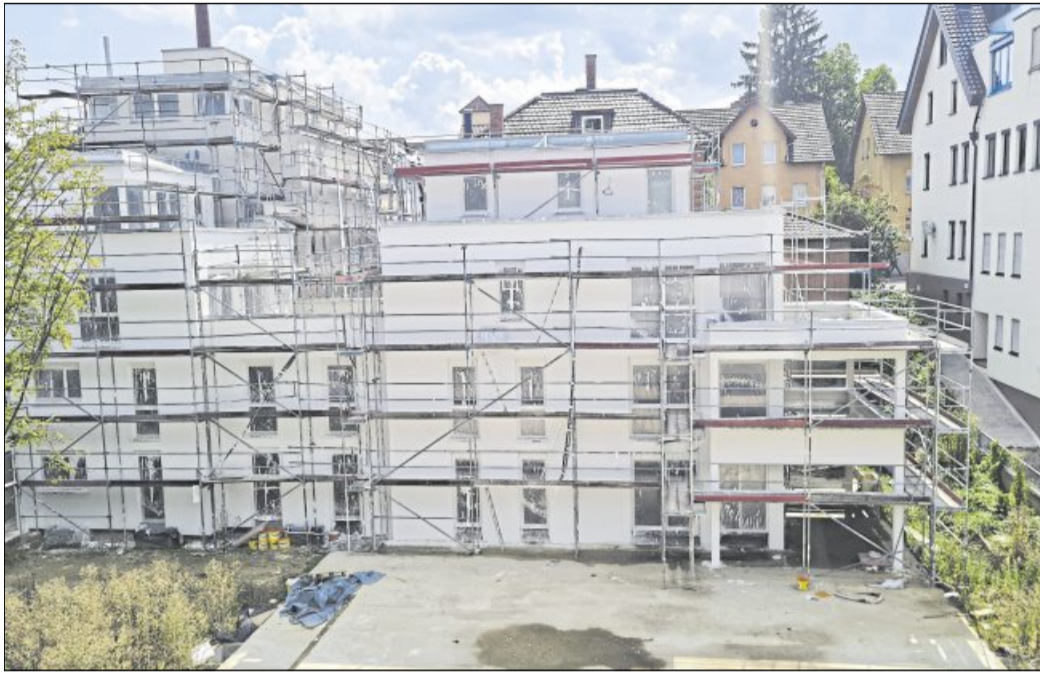
Bei Neubauten, wie in der Bahnhofstraße in Waiblingen, wächst das Gerüst mit dem Rohbau. Wichtig für die Gerüstbauer von Pagel ist hier, eng mit dem Bauleiter, dem Polier und anderen beteiligten Gewerken zusammenzuarbeiten, um Besonderheiten am Gebäude, wie etwa Erker, rechtzeitig berücksichtigen zu können. Nur bei Fertighäusern gilt: erst das Gerüst, dann der Aufbau.
